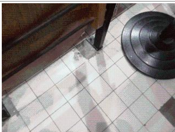
Prélèvement - P23 : BAT L0 / RDC / AMPHITHEATRE - Colle de carrelage- (Absence d'amiante)
