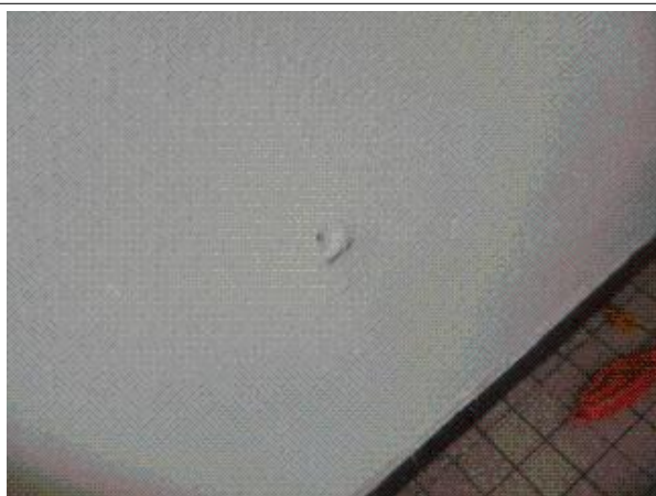
Prélèvement - P9 : BAT L0 / RDC / SANITAIRES - Enduit- (Absence d'amiante)
