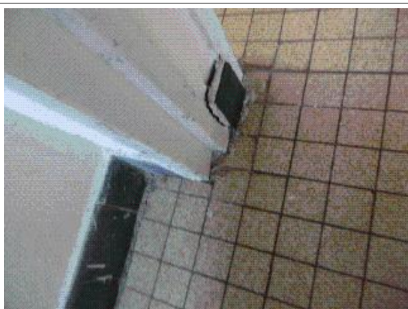
Prélèvement - P3 : BAT L0 / RDC / SANITAIRES - Colle de plinthe- (Présence d'amiante)
