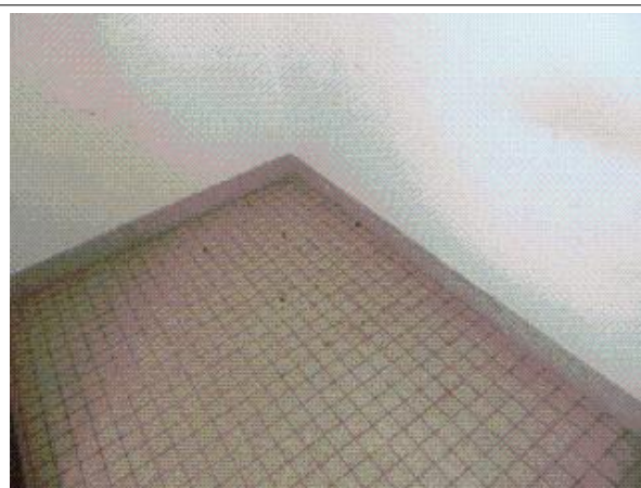
Prélèvement - P6 : BAT L0 / RDC / SANITAIRES - Colle de plinthe- (Absence d'amiante)
