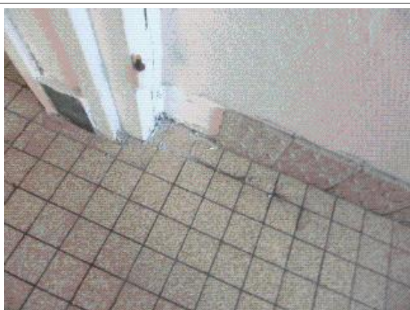
Prélèvement - P5 : BAT L0 / RDC / SANITAIRES - Colle de plinthe- (Absence d'amiante)
