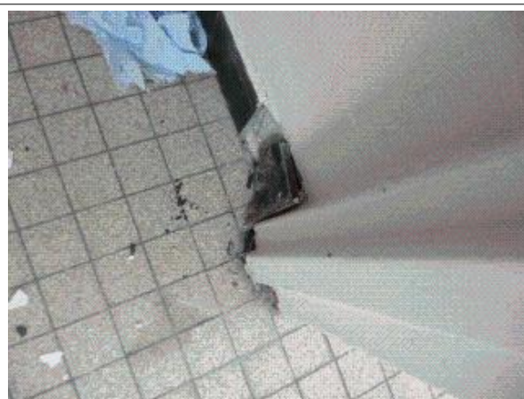
Prélèvement - P4 : BAT L0 / RDC / SANITAIRES - Colle de plinthe- (Présence d'amiante)
