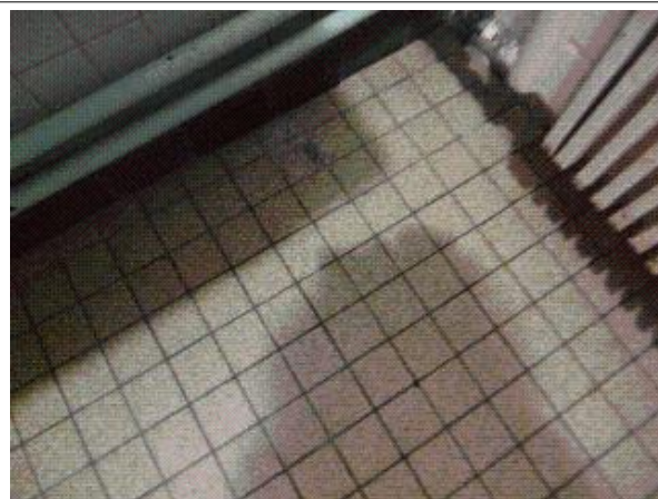
Prélèvement - P2 : BAT L0 / RDC / SANITAIRES - Colle de carrelage- (Absence d'amiante)
