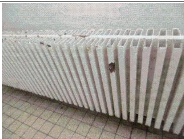
Prélèvement - P17 : BAT L0 / RDC / SANITAIRES - Peinture- (Absence d'amiante)
