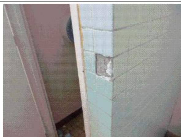
Prélèvement - P16 : BAT L0 / RDC / SANITAIRES - Colle de faïence- (Présence d'amiante)
