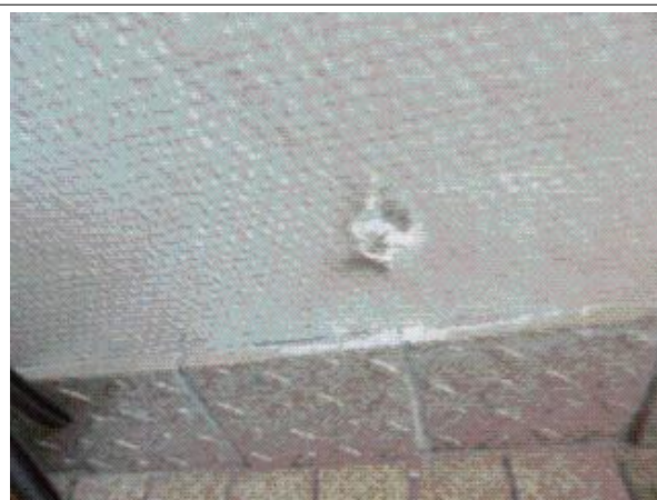
Prélèvement - P12 : BAT L0 / RDC / SANITAIRES - Enduit- (Présence d'amiante)
