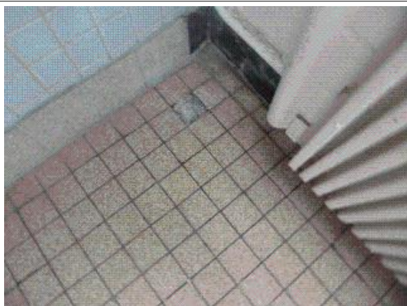
Prélèvement - P1 : BAT L0 / RDC / SANITAIRES - Colle de carrelage- (Absence d'amiante)
