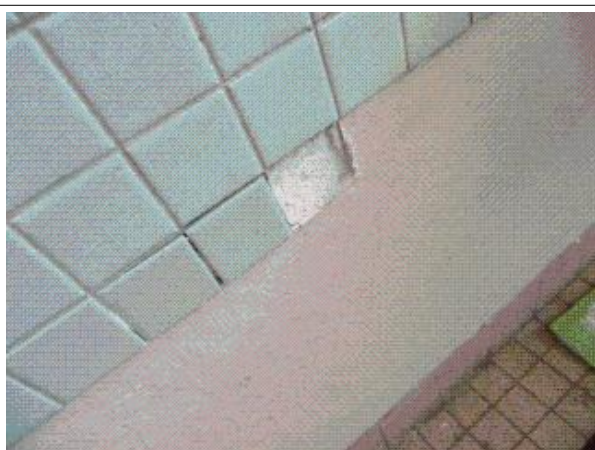
Prélèvement - P15 : BAT L0 / RDC / SANITAIRES - Colle de faïence- (Présence d'amiante)
