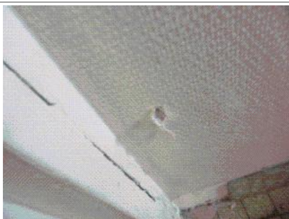
Prélèvement - P11 : BAT L0 / RDC / SANITAIRES - Enduit- (Présence d'amiante)
