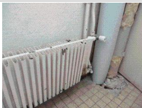
Prélèvement - P18 : BAT L0 / RDC / SANITAIRES - Peinture- (Absence d'amiante)
