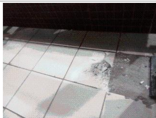
Prélèvement - P24 : BAT L0 / RDC / AMPHITHEATRE - Colle de carrelage- (Absence d'amiante)
