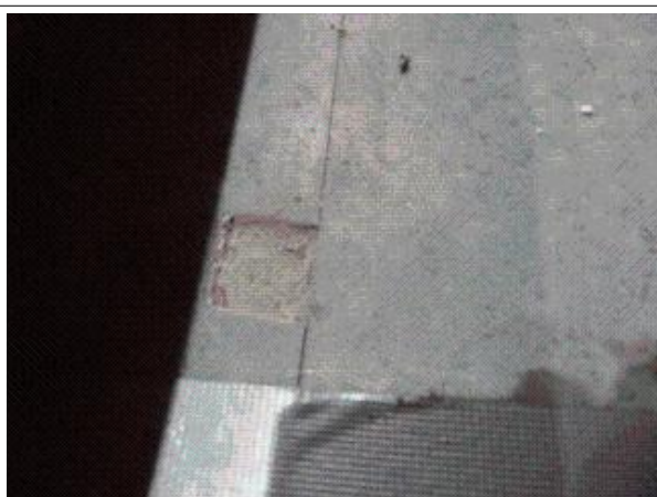
Prélèvement - P27 : BAT L0 / RDC / AMPHITHEATRE - Colle- (Absence d'amiante)
